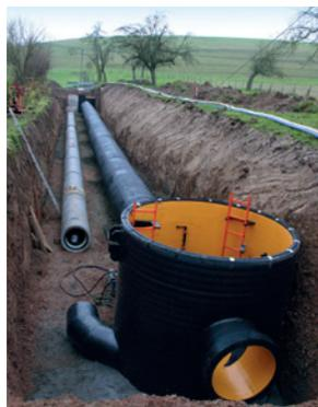
Der Kanal wurde im unteren Bereich (Weg nach Boos) als Staukanal ausgebaut, um einen kontrollierten Abfluss zu gewährleisten. Der Staukanal ist ca. 50 m lang, hat einen Durchmesser von 1200 mm und kann rund 50 m³ Wasser aufnehmen. Am Ende des Staukanals ist eine Steuerung (Durchflussregulierung) eingebaut,
