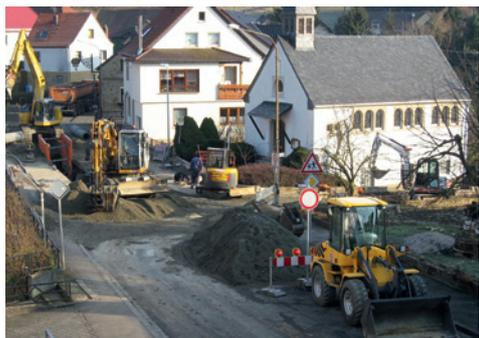
Allee wirkte an manchen Tagen wie eine Großbaustelle, da teilweise bis zu fünf Bagger gleichzeitig im Einsatz waren. Der Kanal und die neue Wasserleitung sind verlegt. Die Herstellung der Oberflächen in der Allee ist in vollem Gange. (Weiteres dazu im eigenen Bericht.)
